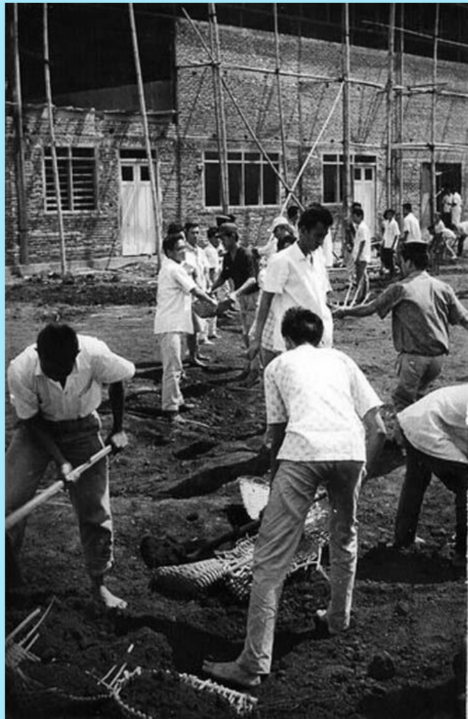
Mahasiswa URECA sedang Bekerja Bakti membangun Gedung URECA, 1962
